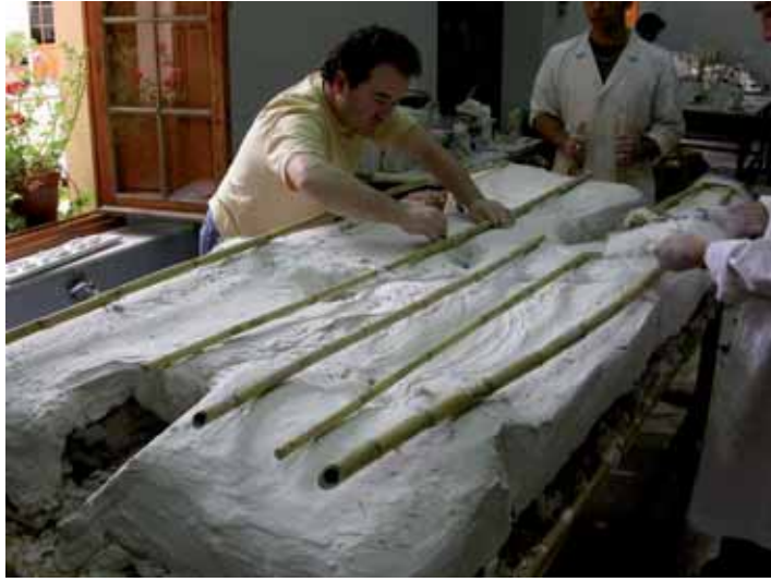
Figuras 18 y 19. Construcción de cuadrícula de cañas como sistema de refuerzo
