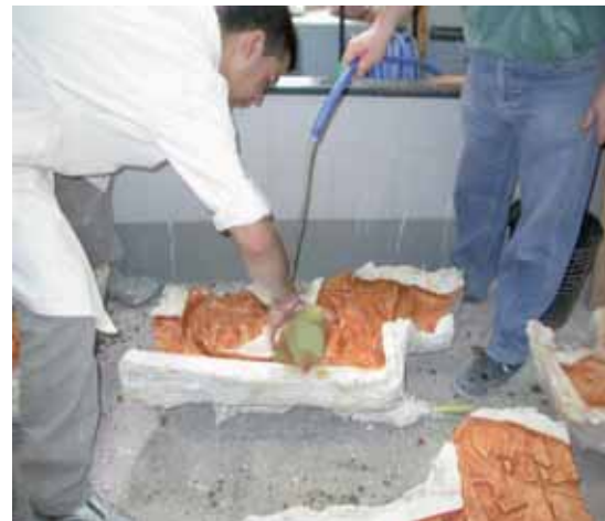
Figuras 22 y 23. Eliminación del barro y limpieza del molde
