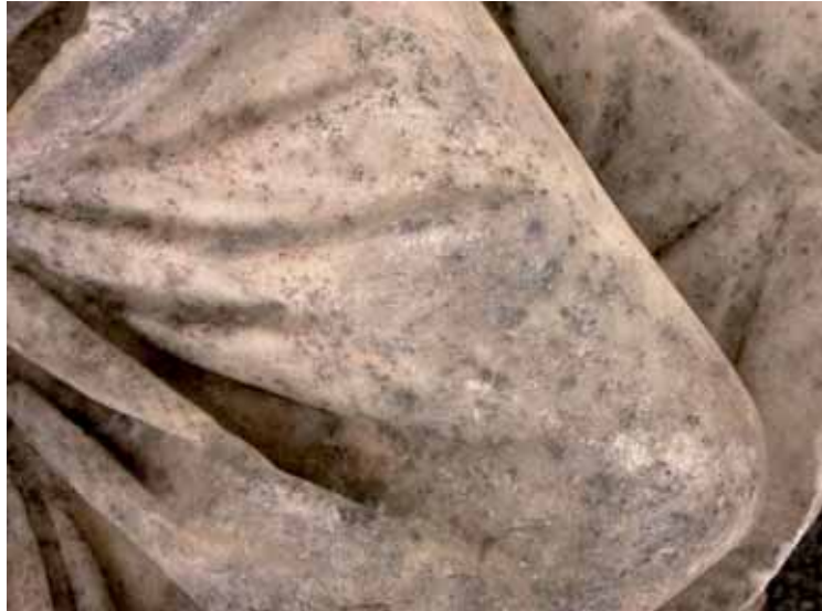
Figura 9. Moteado y pátina de alteración
