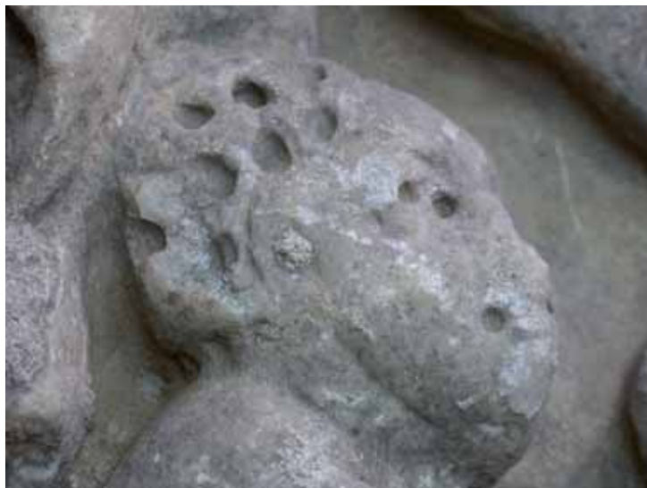
Figura 8. Superficie erosionada y cubierta por carbonato cálcico
