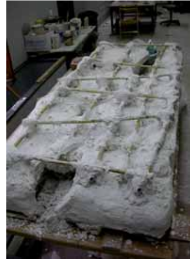
Figuras 18 y 19. Construcción de cuadrícula de cañas como sistema de refuerzo
