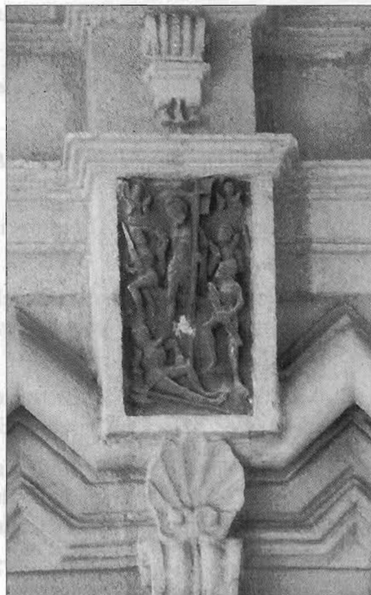
Fot. 02 - Aspecto general de deterioro que presentaba la obra antes de su recuperación y traslado al Museo.
