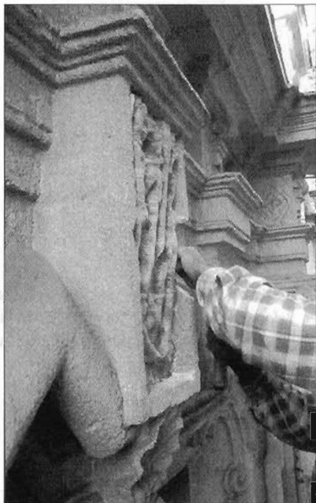
Fot. 04 - Procedimiento de extracción de la obra, la superficie del relieve se protegió con un engasado rígido.
